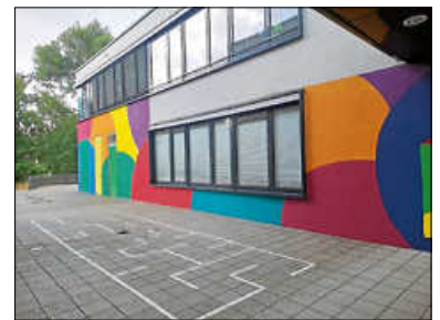
Mensawand mit Begegnungsfläche zur Gemeinschaftsschule
