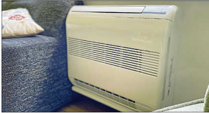
Sogenannte Klimasplitgeräte können neben dem Kühlen auch zum Heizen eingesetzt werden Foto: LEA
