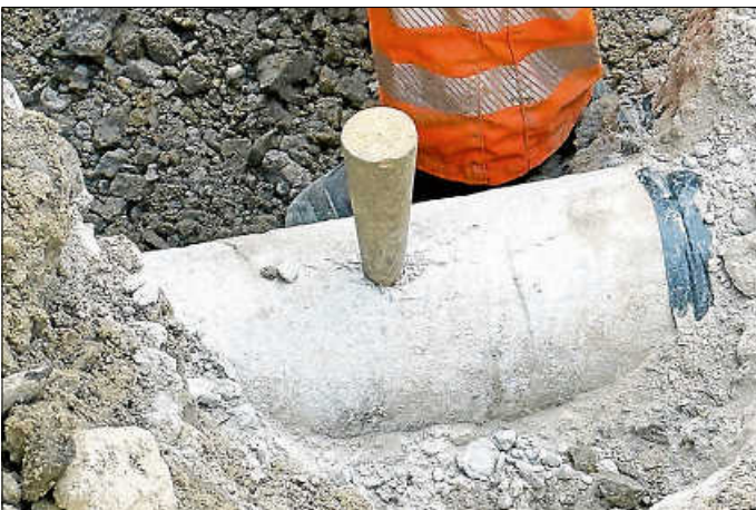
Die Gasleitung wurde abgedichtet
