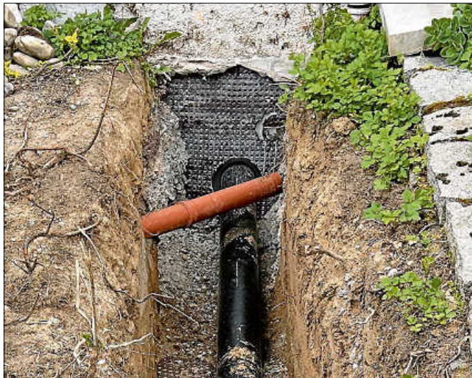
Gebäudeanschluss an ein Wärmenetz
