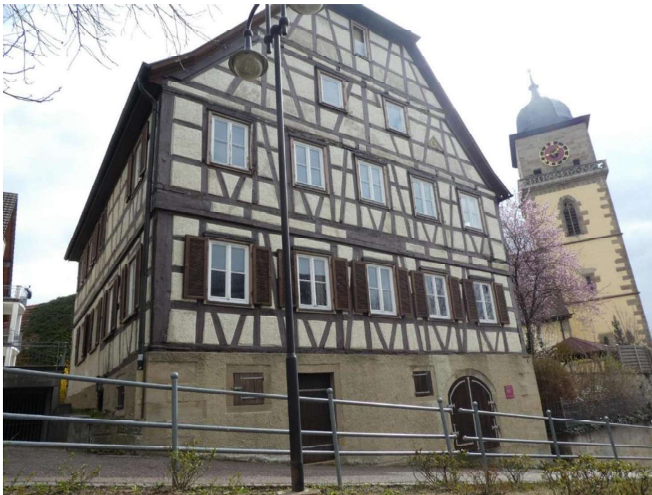
Abbildung 1: Georgskirche und angrenzendes Gebäude Eugen-Hermann-Straße 4
