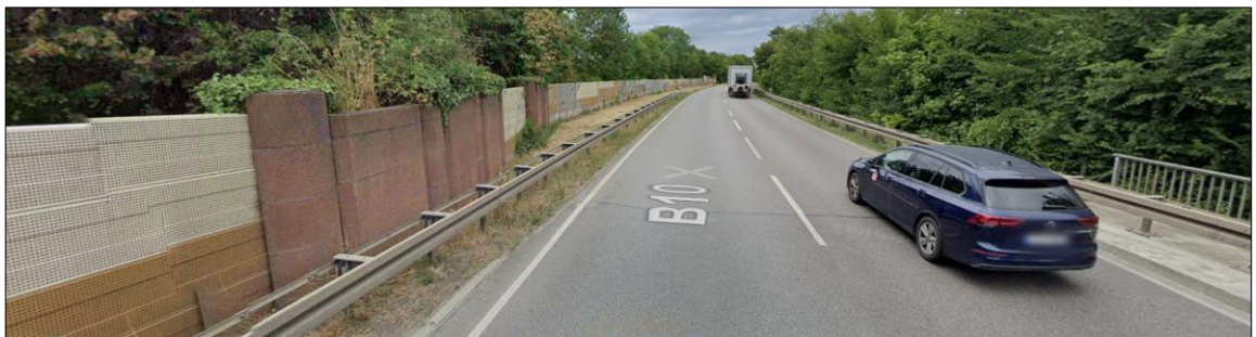
Abbildung 14: Lärmschutzwand, B 10 Schwieberdingen
