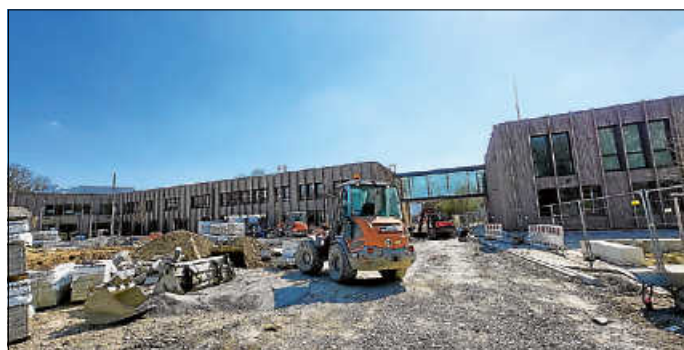
Neubau und saniertes Bestandsgebäude der Glemstalschule sind künftig durch den gläsernen Durchgang verbunden
