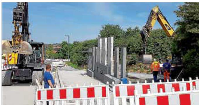
In dieser Woche werden die Straßenbauarbeiten im letzten Bauabschnitt fortgeführt. Dazu werden die Schottertragsschichten eingebaut, damit die Asphaltsschichten bis Ende Juni eingebaut werden können.
